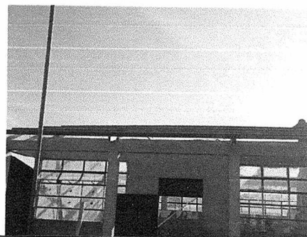
Foto 2: cambio de techo de aula.
