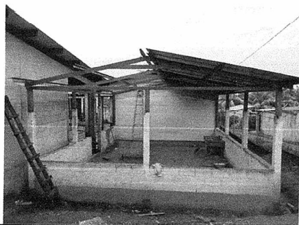
Foto 1: Colocacion estructura de techo para la cocina.
